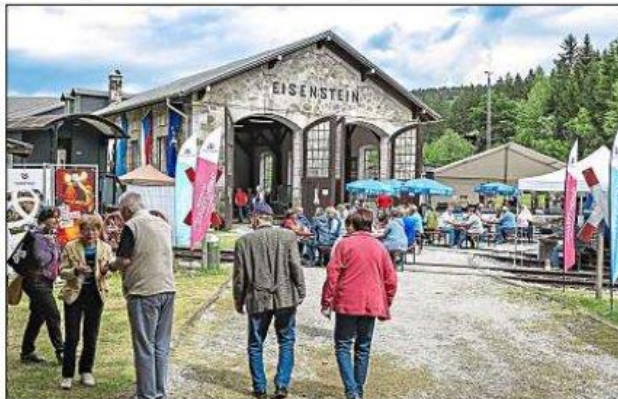
Das Ambiente des Localbahnmuseums konnte bei Besuchern und Veranstaltern gleichermaßen punkten. – Fotos: Bietau
